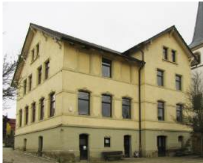
Abb.64: Ehem. Schulhaus, Herrengasse 6
