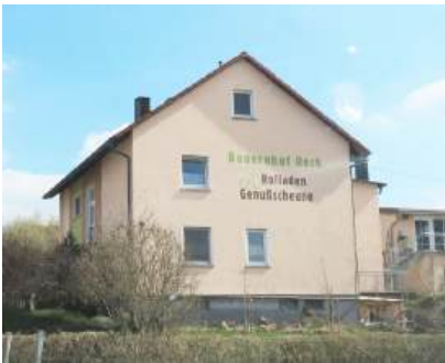
Abb.33: Bauernhof mit Hofladen, Oberer Grund 1
