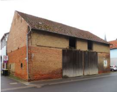
Abb.57: Hambacher Hauptstraße 29: Nebengebäude
