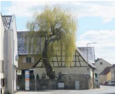
Abb.81: Baum an der Hambacher Hauptstraße
