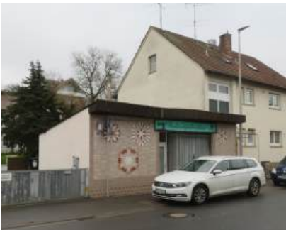
Abb.76: Änderungsschneiderei, Hambacher Hauptstraße 38 (Nebengebäude)
